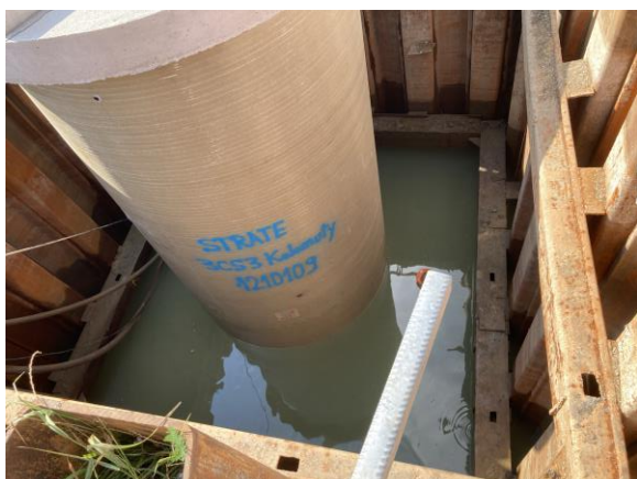
ČSOV 3 – uložení čerpací jímky
