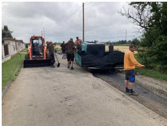
Výtlak V1 – Řepov – obnova živičných povrchů
