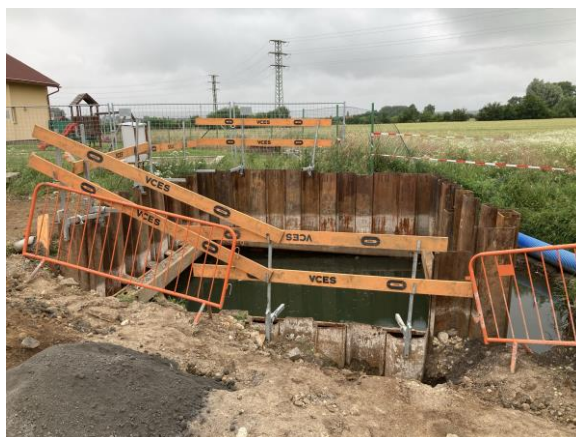
ČSOV 3 – zajištění stavební jámy
