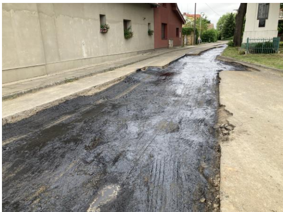
Výtlak V1 – Řepov – infiltrační postřik
