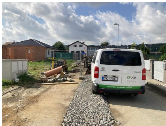
Stoka C.1 – provizorní úprava povrchu nad pokládkou trub
