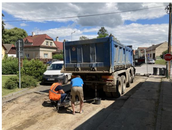
Výtlak V1 – Řepov – statické zkoušky zhutnění
