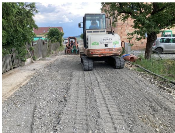
Výtlak V3 – provizorní úprava místní komunikace
