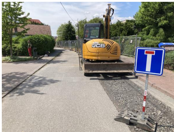
Výtlak V1 – zabezpečení pracoviště v Řepově
