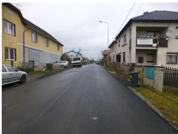
Oprava povrchů komunikací
