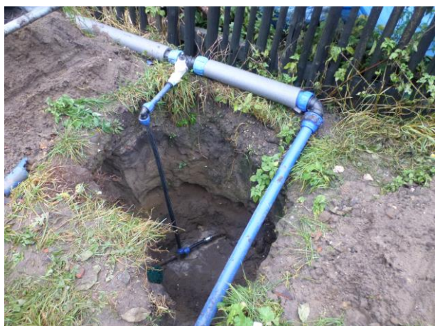
Přeložka vodovodu – provizorní rozvod
