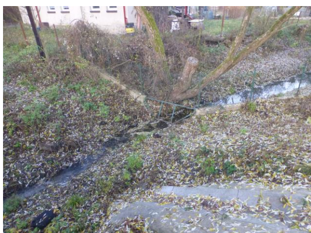
Místo podchodu vodoteče na V1
