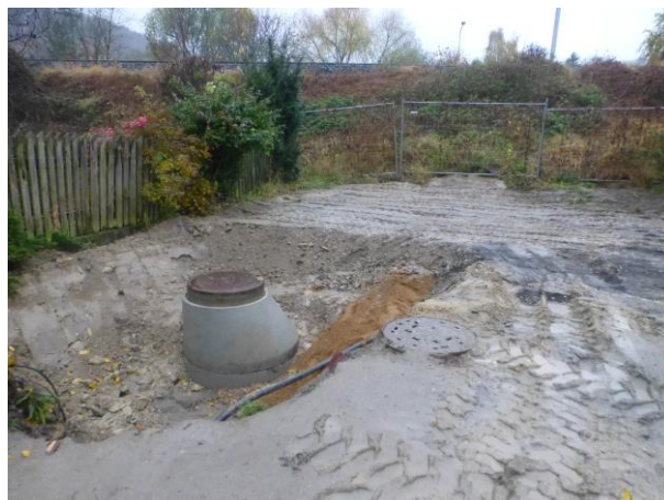
Napojení stoky A po zásypu
