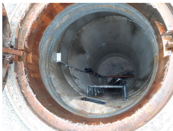
Zaústění tlakové přípojky do revizní šachty
