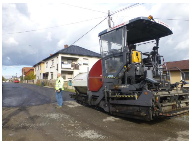
Oprava povrchů komunikací
