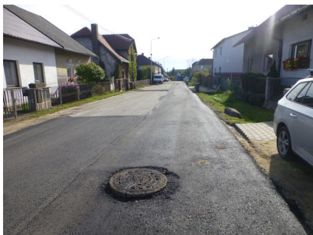
Oprava povrchů komunikací
