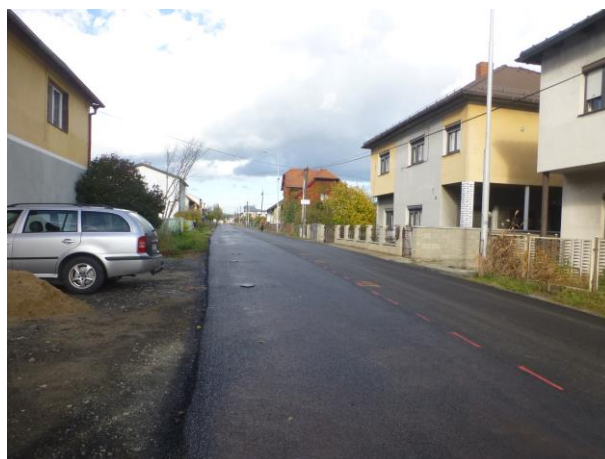
Oprava povrchů komunikací
