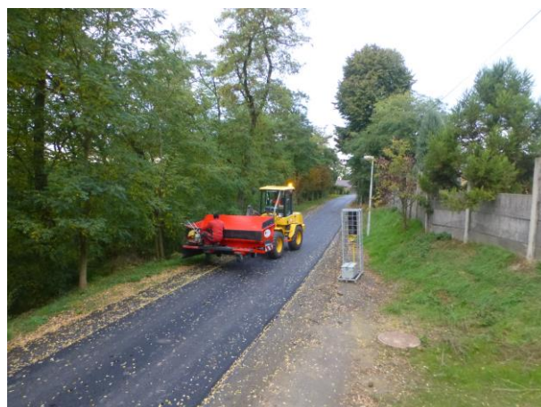
Oprava povrchů komunikací
