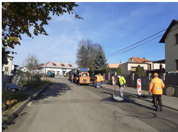
Oprava povrchů komunikací
