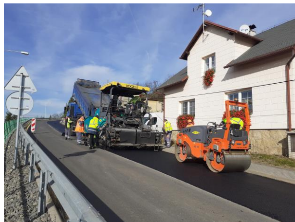
Oprava povrchů komunikací
