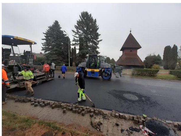
Oprava povrchu komunikací
