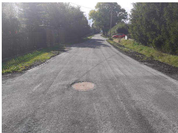
Oprava povrchů místních komunikací
