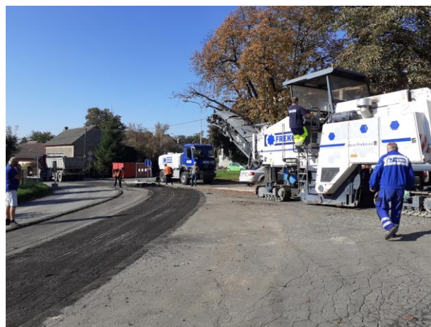
Frézování komunikací
