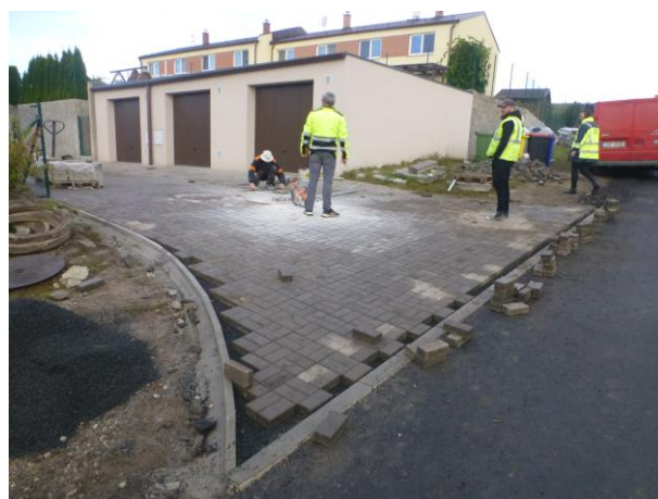
Oprava povrchu komunikací
