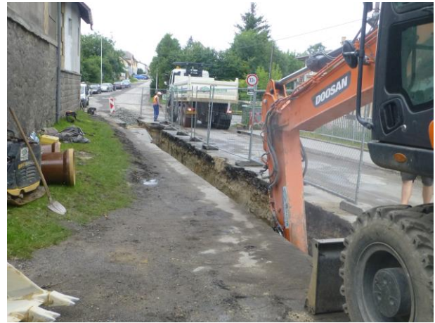
Stoka C1 výkop, frézování skály
