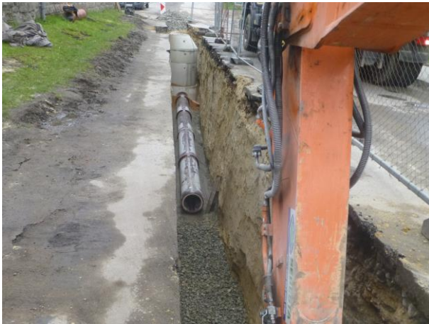
Stoka C1 rýha, položené potrubí
