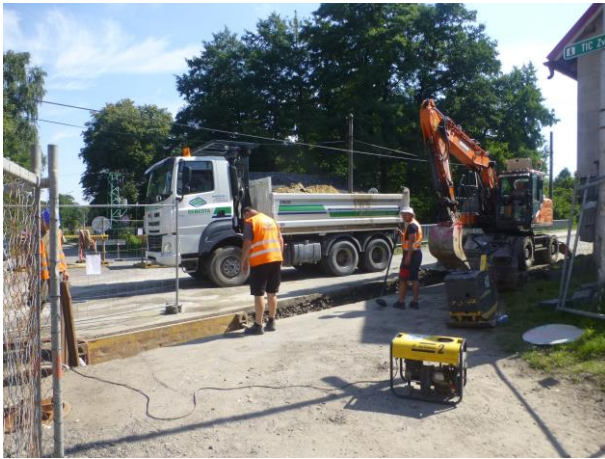
Stoka C1 výkop
