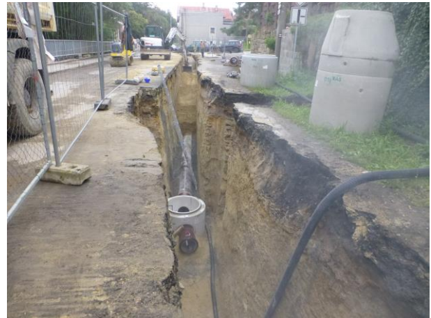
Stoka C1 rýha, položené potrubí
