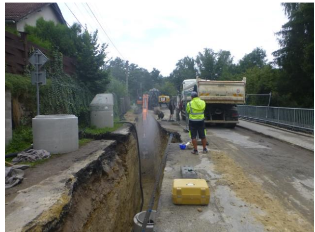
Stoka C1 frézování skály
