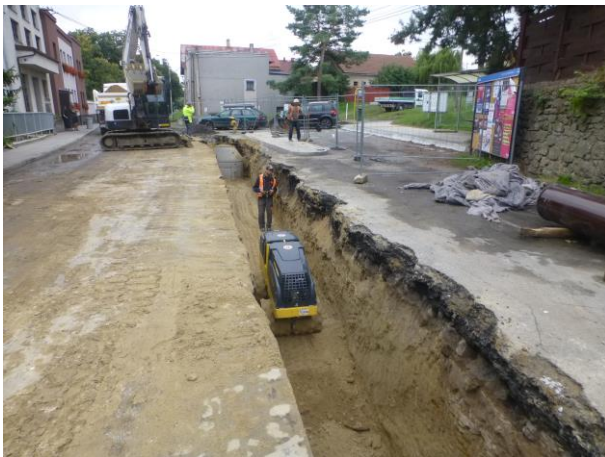
Stoka C1 hutnění zásypů
