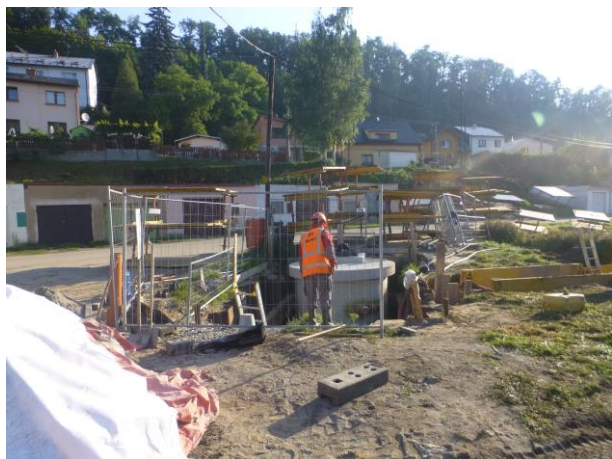
Napojení stoky C u ČSOV 2
