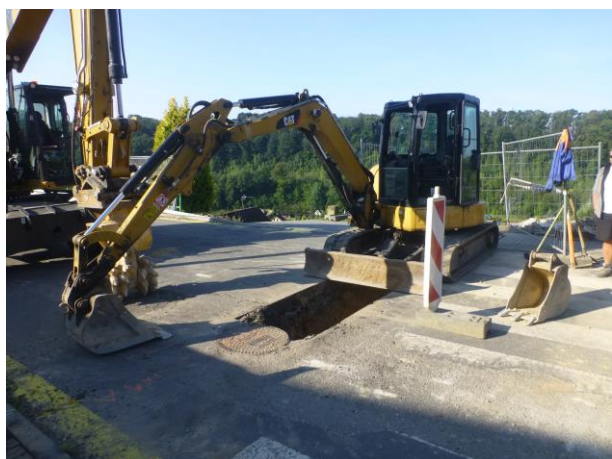
Napojení tlakové přípojky na stoku A
