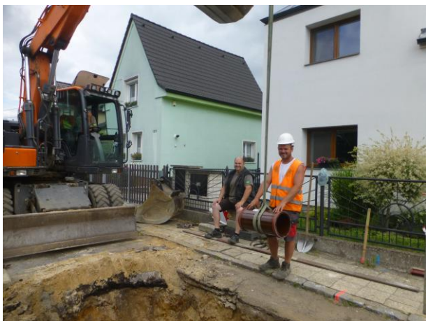
Montáž potrubí stoky C5.2
