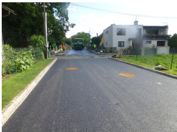
Obnova povrchů místních komunikací
