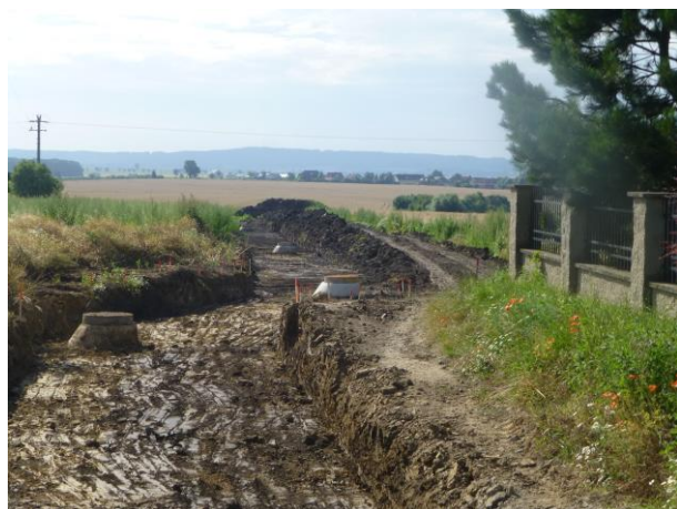
Výkop pro příjezdovou komunikaci ČS1
