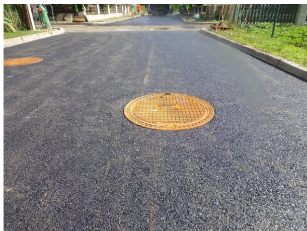
Obnova povrchů místních komunikací
