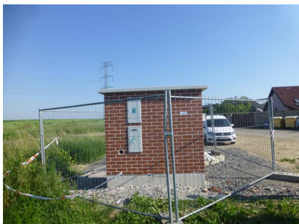
Pilíř Čerpací stanice ČS5
