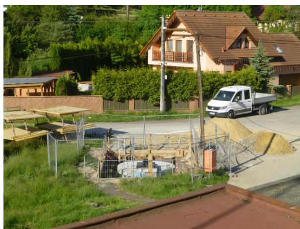
Pohled na ČS2 a stoku C1
