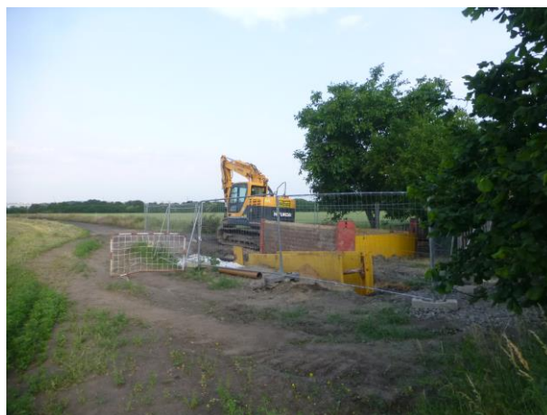
Výkop pro ČS2 Chaloupky
