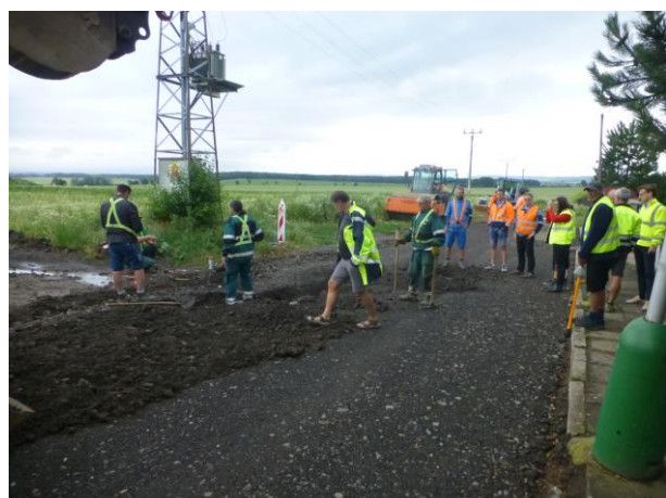
Kontrolní den – úprava povrchu Powercem
