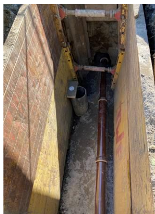
Stoka B – pokládka trub kanalizační přípojky
