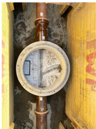
Stoka BA-1 – osazení šachtového dna
