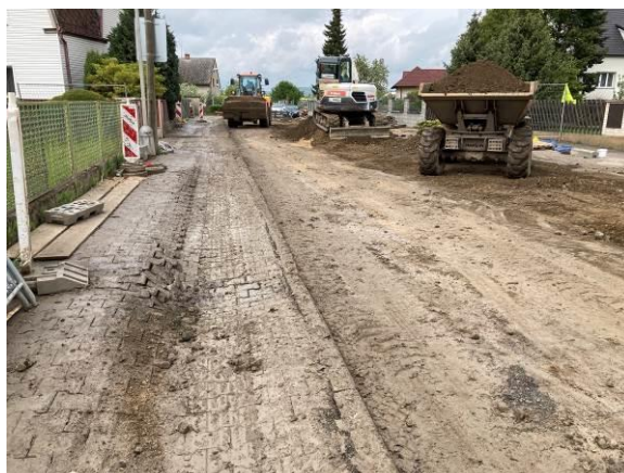
Stoka B – provizorní úprava povrchu komunikací
