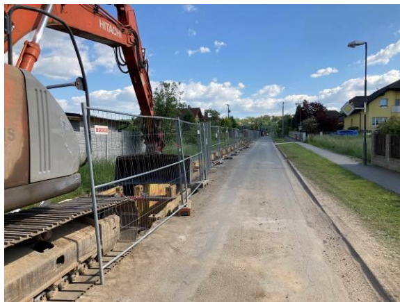
Stoka BA-1 – zabezpečení stavební rýhy
