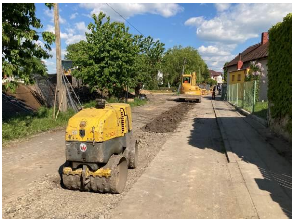
Výtlak V1 – hutnění stavební rýhy v Řepově
