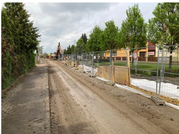
Stoka B – zabezpečení stavební rýhy
