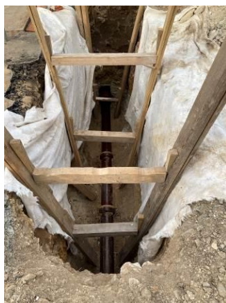
Stoka A.5 – realizace veřejné části kanalizační přípojky
