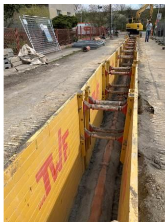
Stoka A.5 – pokládka kanalizačních trub
