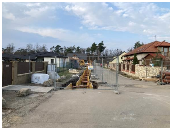
Stoka B.5 – zajištění pracoviště
