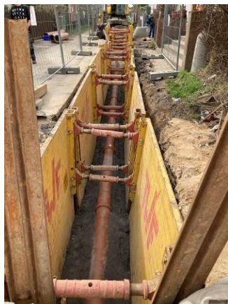
Stoka A – pokládka kanalizačních trub
