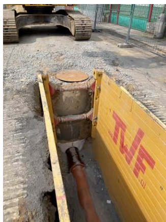
Stoka A.5 – osazení šachty
