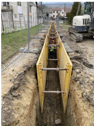
Stoka A.6 – zajištění stavební rýhy
