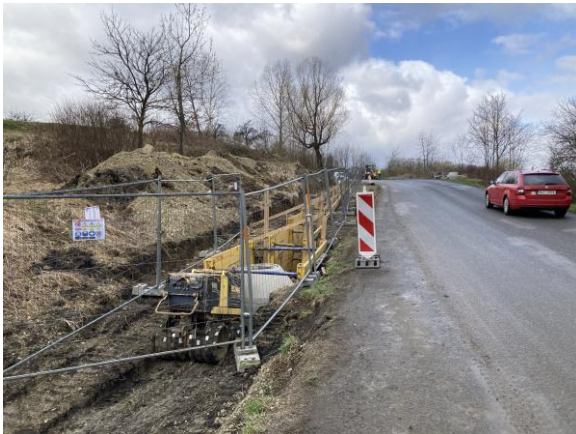
Stoka A – kanalizační přivaděč – zajištění pracoviště
