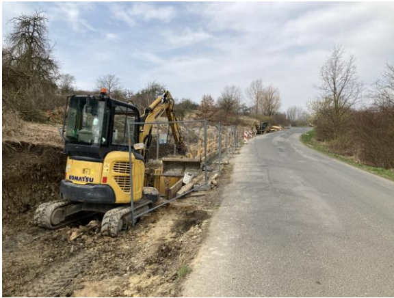
Stoka A – kanalizační přivaděč – zajištění pracoviště
