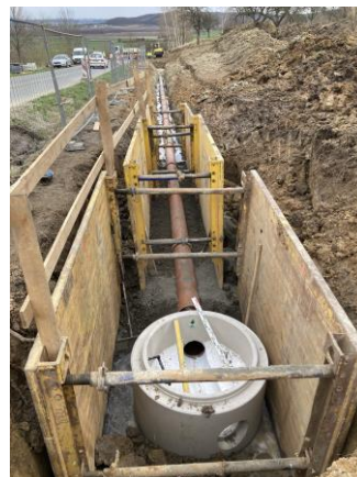
Stoka A – kanalizační přivaděč – osazení šachtového dna
