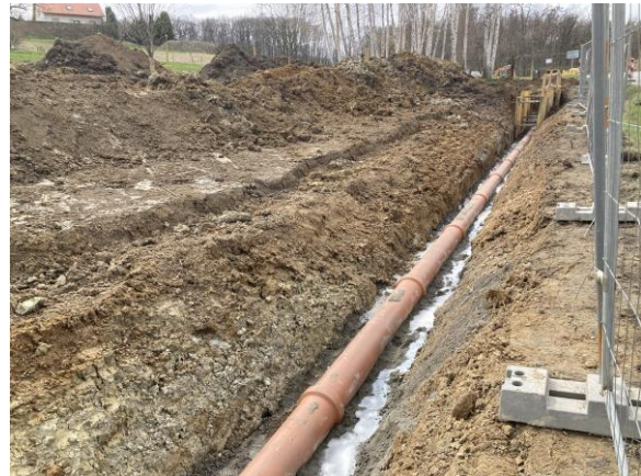
Stoka A – kanalizační přivaděč – pokládka kanalizačních trub
