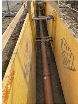
Stoka A – kanalizační přivaděč – pokládka kanalizačních trub
