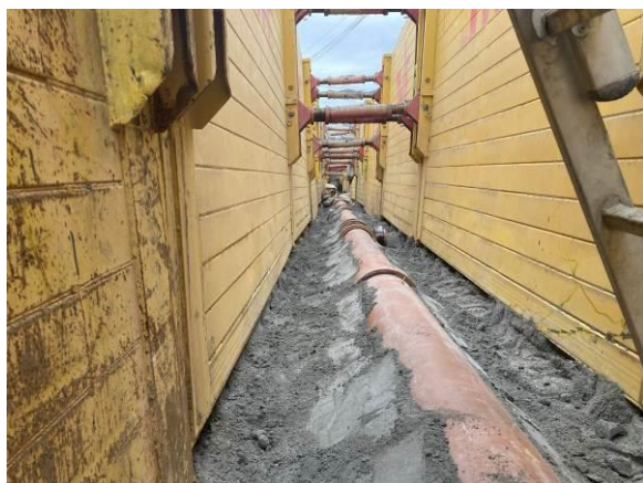
Stoka B.5 – betonové sedlo
