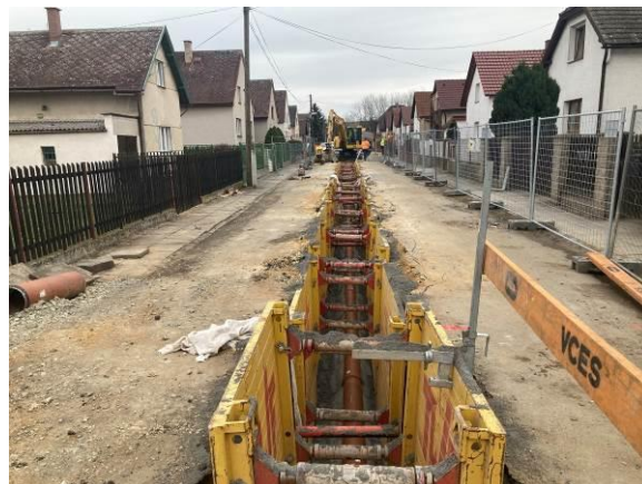
Stoka A – pokládka kanalizačních trub
