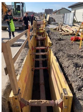
Stoka B.5 – pokládka kanalizačních trub
