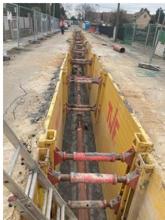
Stoka A.5 – pokládka kanalizačních trub
