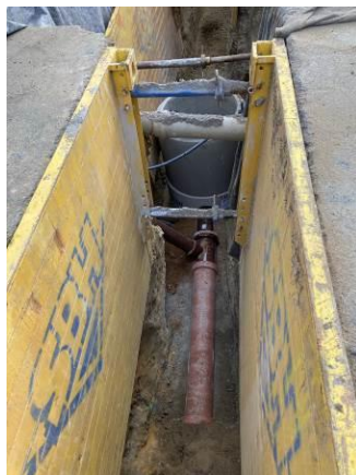
Stoka A – pokládka kanalizačních trub
