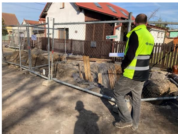
Vodovod V3 – zajištění pracoviště
