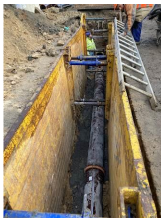
Stoka A – pokládka kanalizačních trub
