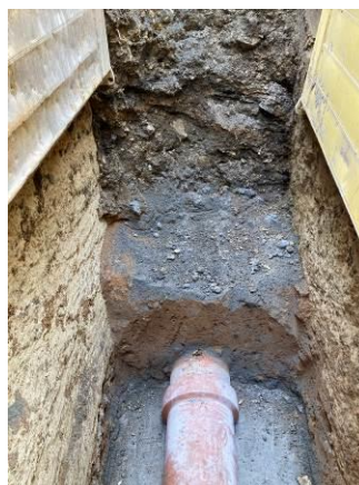
Stoka A.1 – napojení na již realizovanou část
