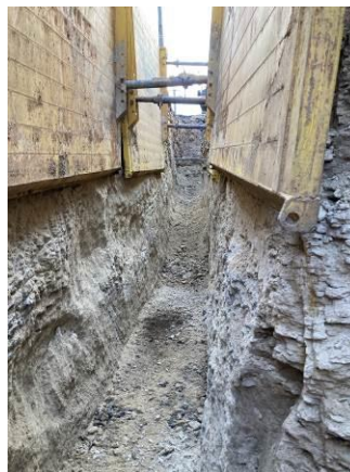
Stoka A – zajištění stavební rýhy
