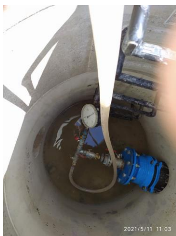
Zkouška těsnosti-výtlak Brodce
