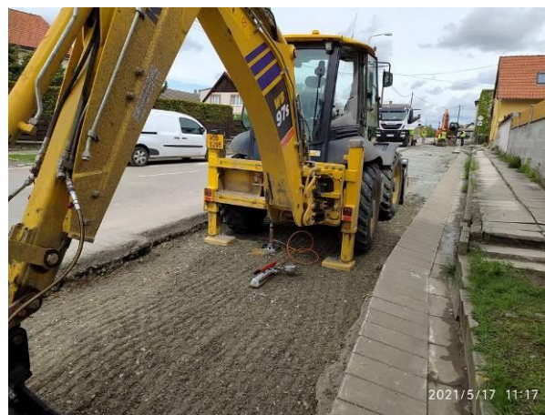
Statická zatěž.zkouška ul.RA
