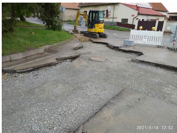
Podkladní vrstvy komunikace RA
