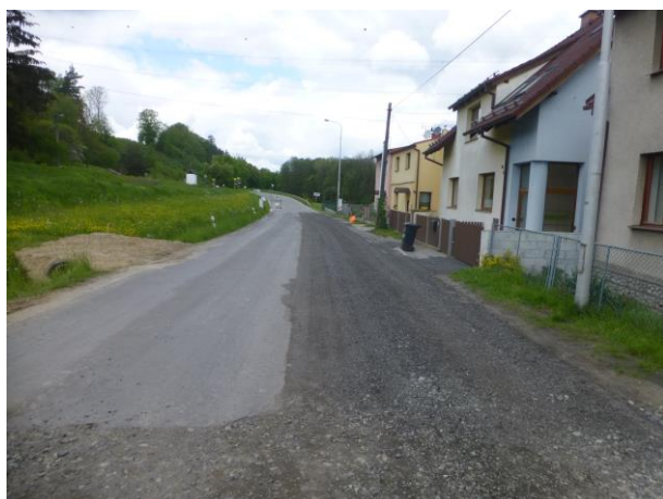
Provizorní povrchy komunikací
