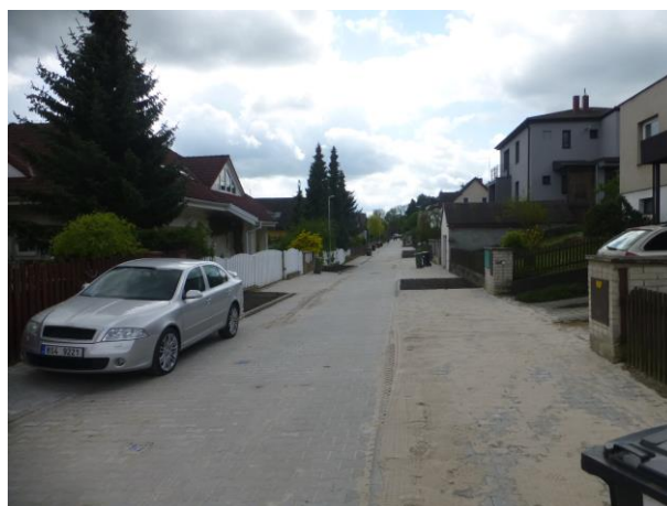
ul. Za Tratí 2 – realizace komunikace Colas
