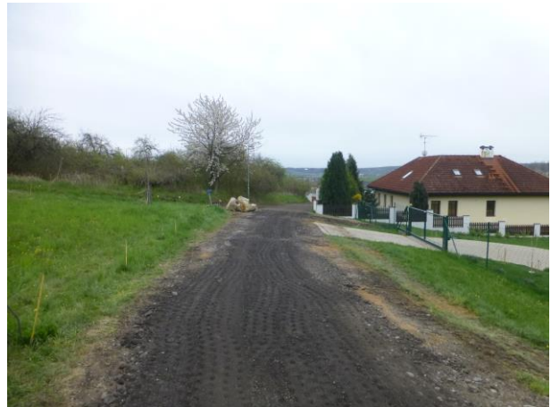
Výtlak V3 – úprava povrchu
