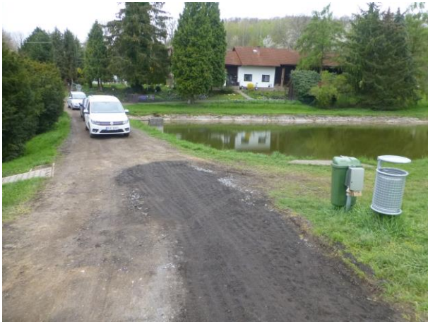
Výtlak V3 – úprava povrchu
