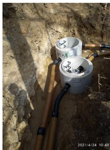
Osazení šachet na výtlačném řadu
