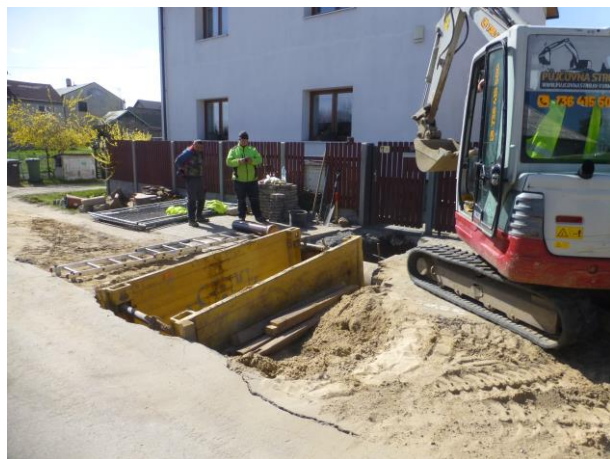
Stoka C – kanalizační přípojka
