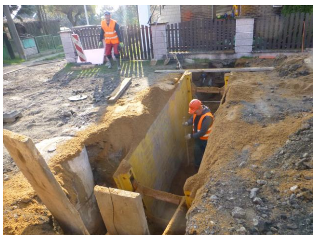
Kanalizační přípojka stoka BD
