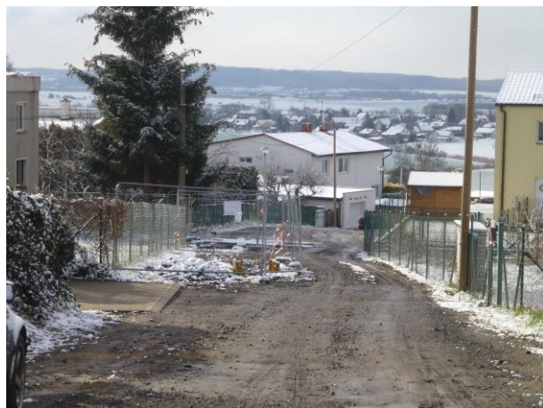
Přeložka vodovodu na BD4
