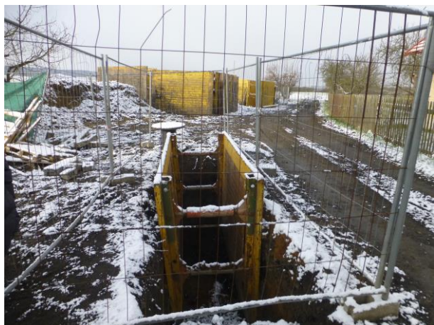
Pracoviště Chaloupky – stoka A, V1
