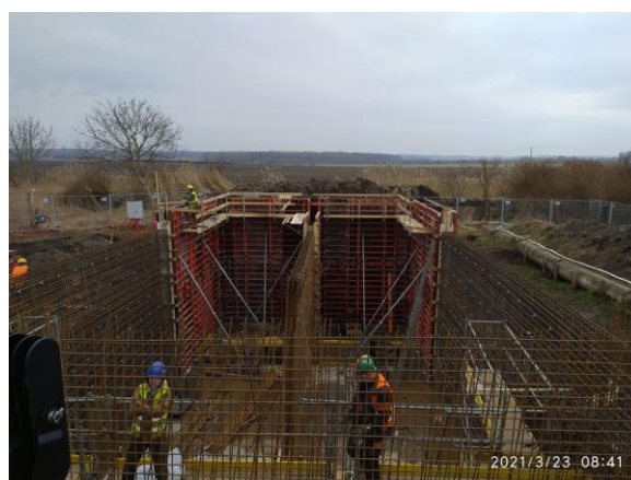
ČOV-výztuž stěn nádrží
