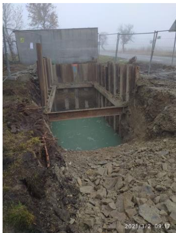
Zemní práce ČS II.
