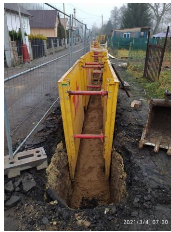
Zásyp výtlačného řadu Vinec
