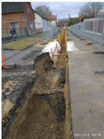
Vodovod v souběhu se stokou E
