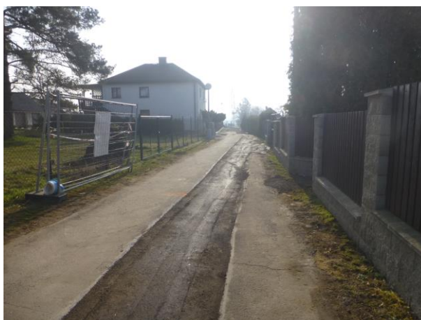
Stoka AC – provizorní povrchy
