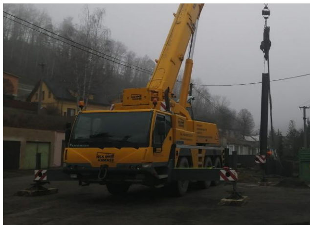
ČS2 – montáž štětovnice
