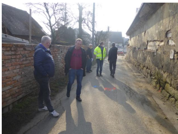
Stoka AG – vyměřování před zahájením přeložek
