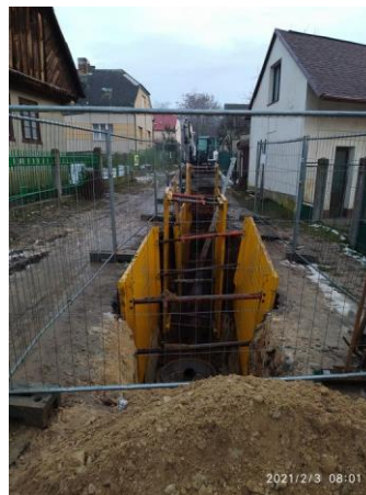
Kanalizační stoka 2S-5c
