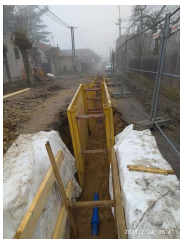
Vodovodní řad v souběhu se stokou E
